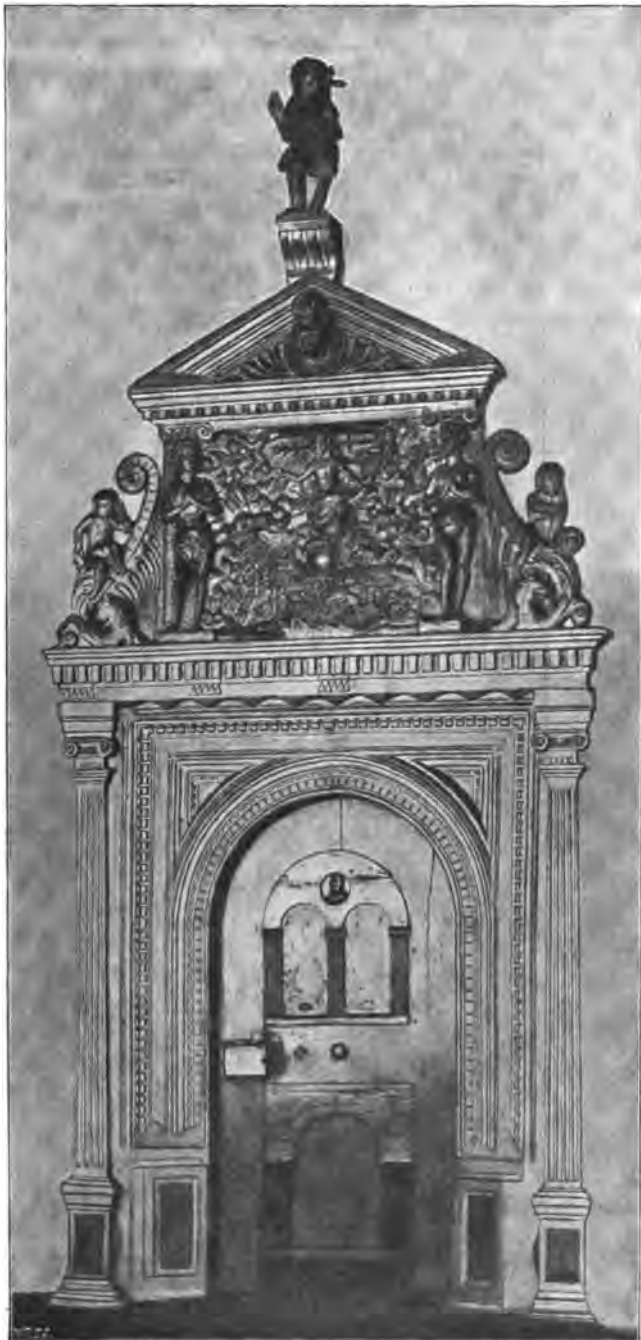
Thür im Altenburger Rathhaus vom Oberbürgermeister-Zimmer zum Vorsaal.
